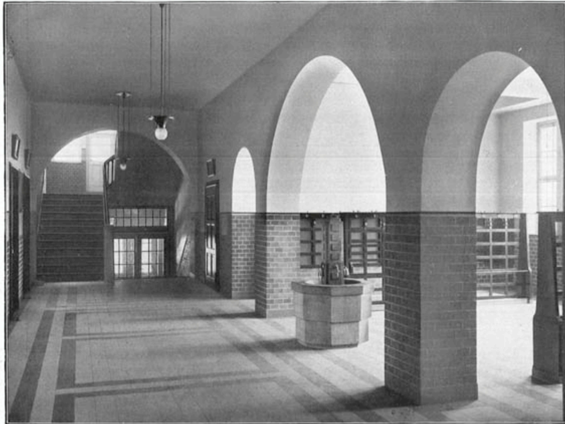
Hallgartenschule. I. Obergeschoß. Korridor mit Kleiderablage.
