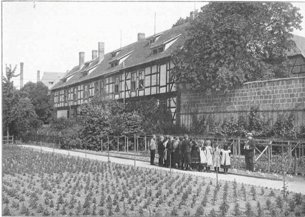
Schulhaus mit Schulgarten.
