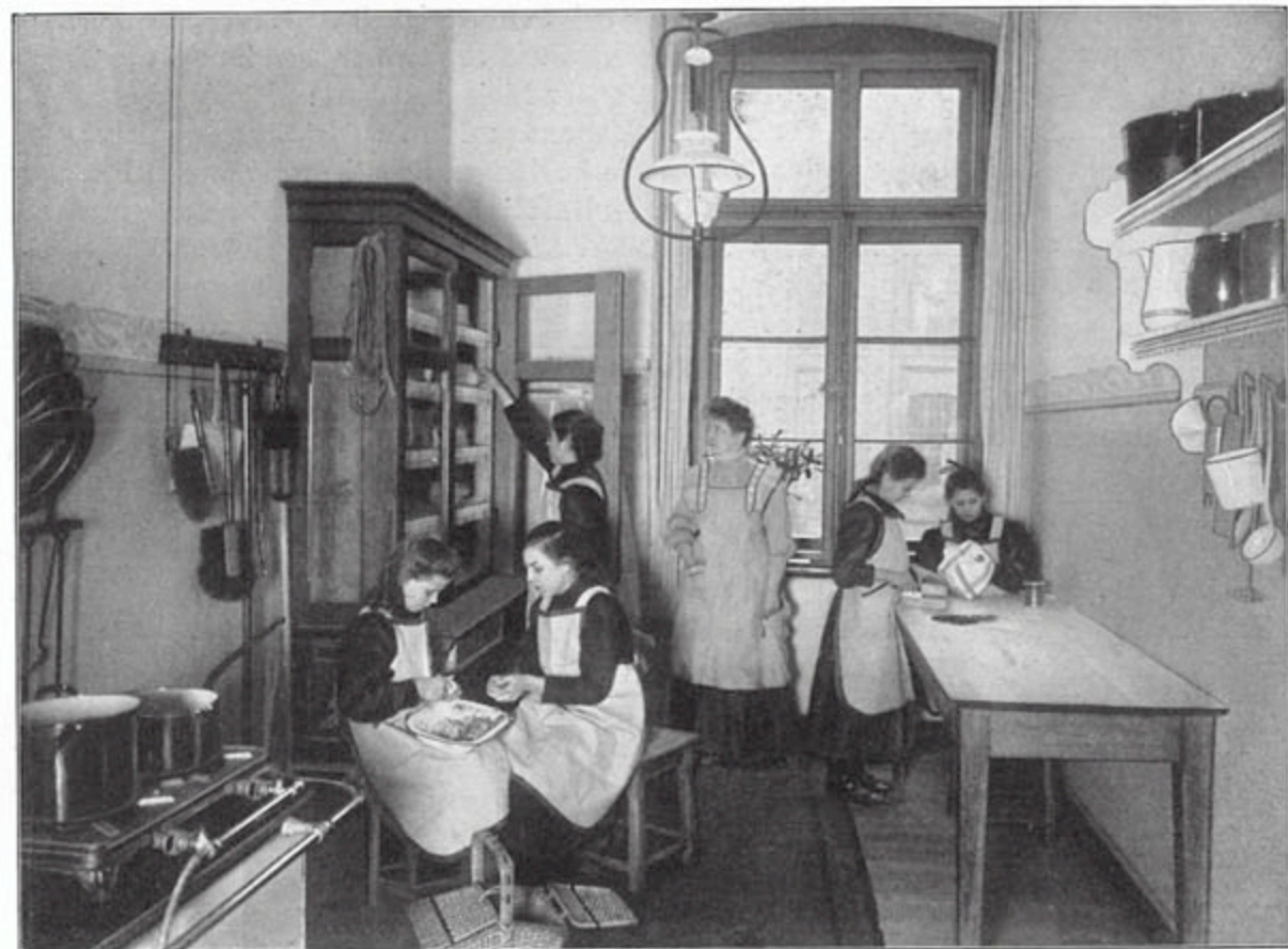
Schulküche in der II. Hilfsschule.
