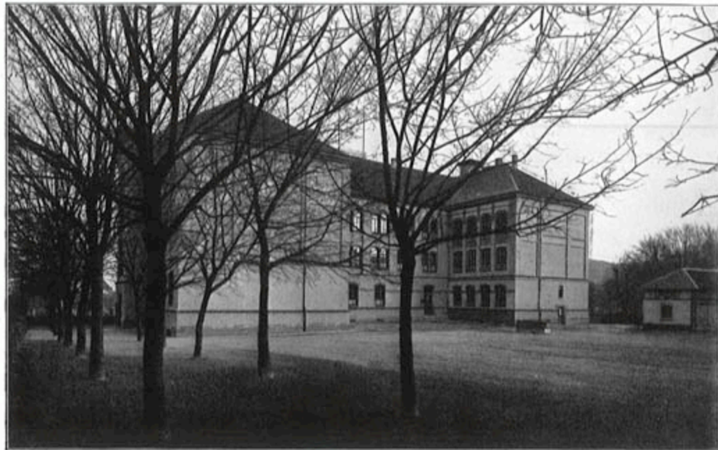
Bürgererschule II zu Blankenburg (Harz). * Nordflügel — für die Hilfsschule —.
